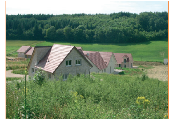
La végétation pré-existante ne semble pas avoir été prise en compte : les broussailles en premier plan témoignent du déracinement du terrain (ici, Fontain).
