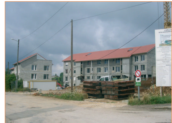
L'opération de Dannemarie-sur-Crête, en cours de réalisation, est un bon exemple : l'ensemble d'habitation va diversifier l'offre en logement, offrir de nouveaux services de proximité (trois commerces créés) et va enrichir le réseau d'espaces publics de la commune.
