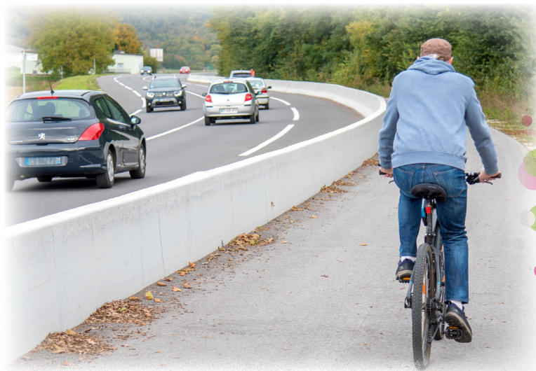
Voie cyclable le long de la D683 (Thise)
