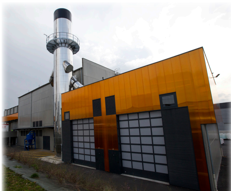
Chaufferie bois de Planoise
