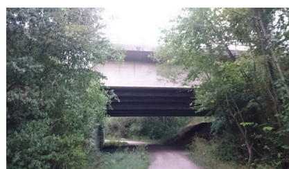
Passage technique sous l'A36 (source : AudaB)
